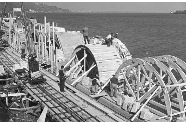
Nuovo viadotto stradale, nei pressi della centrale Verbania, Brissago 1950
