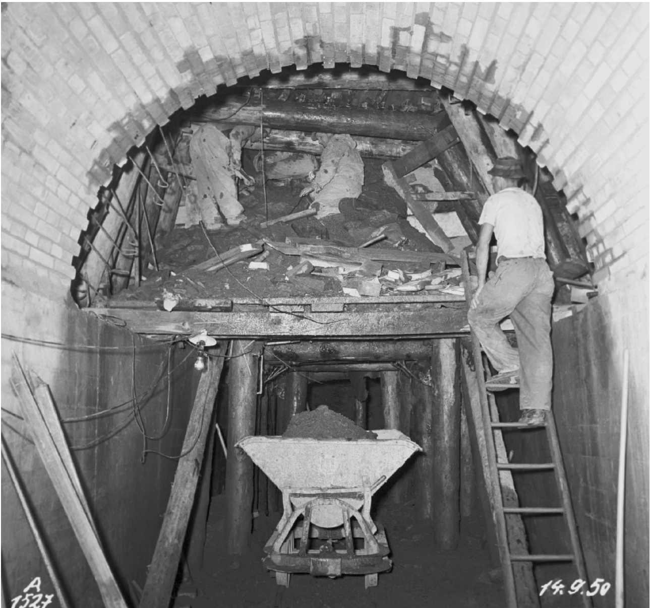
Oben: Brissago, September 1950 – Eine Mannschaft von vier Arbeitern stützt das Gewölbe des Kabelstollens des Kraftwerks Verbano.
