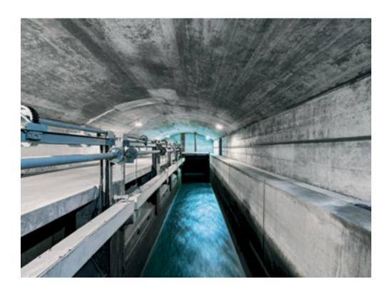
Abflusskanal des turbinierten Wassers, links die Notfallentlastungsschleusen zum Gebirgsbach Bavona
