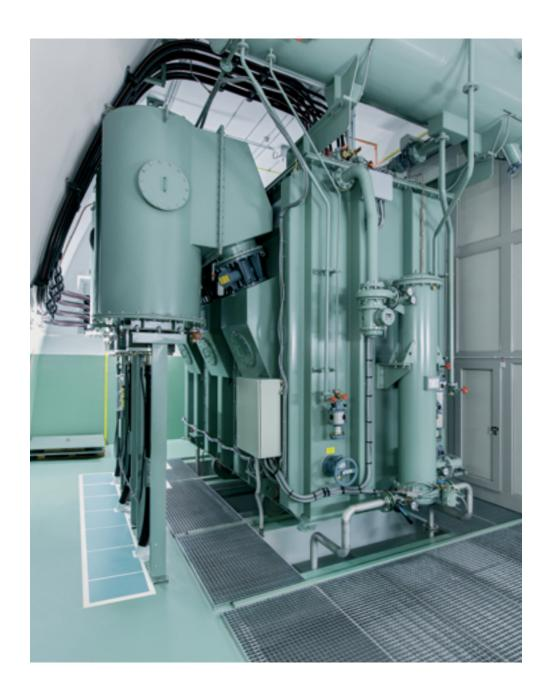
12/220-kV-Transformator von 67 MVA für die Maschinen 3 und 4
