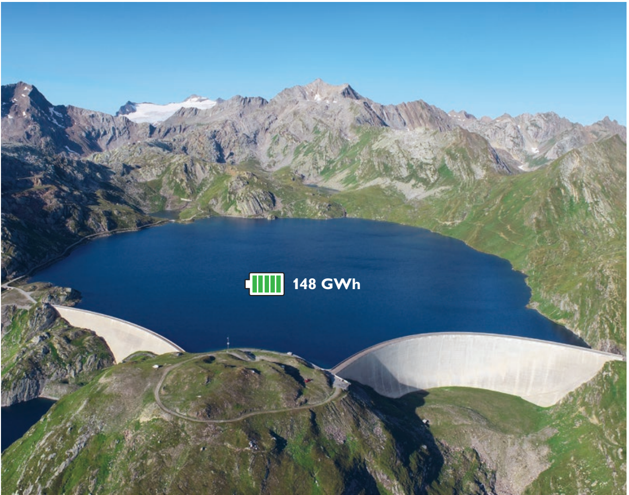
Bacino Naret, corona diga 2310 msm. Capacità di accumulo 31 mio m 3 di acqua, equivalenti a 148 GWh elettrici.
