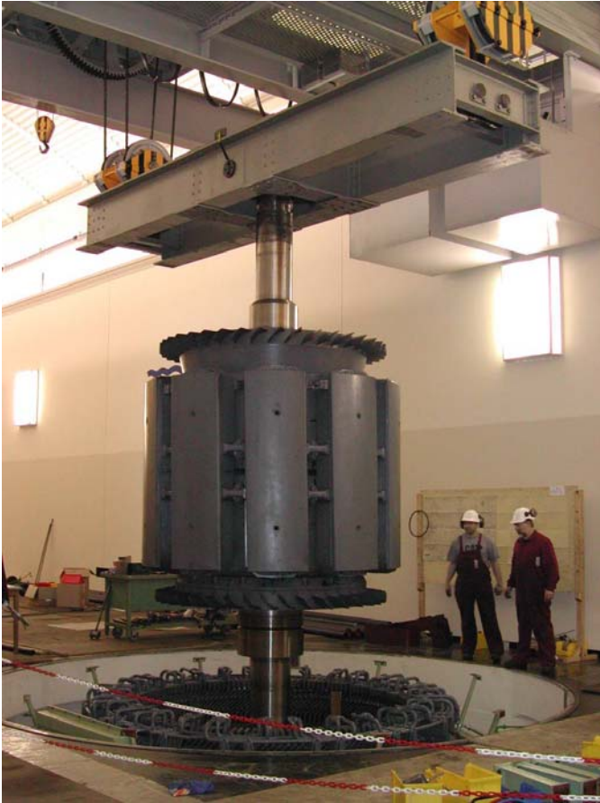
Smontaggio del rotore del generatore no 4 di Verbano
