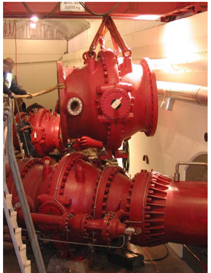
Smontaggio delle valvole sferiche di Verbano
